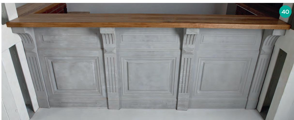
**35–36.** Исторические элементы основания шпиля здания вестибюля станции метро Площадь Восстания. **37–38.** Воссозданные из стеклофибробетона элементы основания шпиля. **39–40.** Барная стойка из стеклофибробетона.
